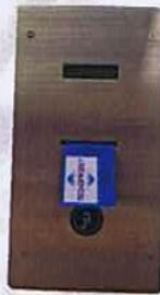
Questo sistema consente di pre-pagare un tempo di utilizzo dell'ascensore creando un credito nella Smart Card, ad ogni corsa il credito di tempo residuo si riduce fino ad esaurimento. Sarà necessario ricaricare la Smart Card per poter utilizzare nuovamente l'ascensore.
